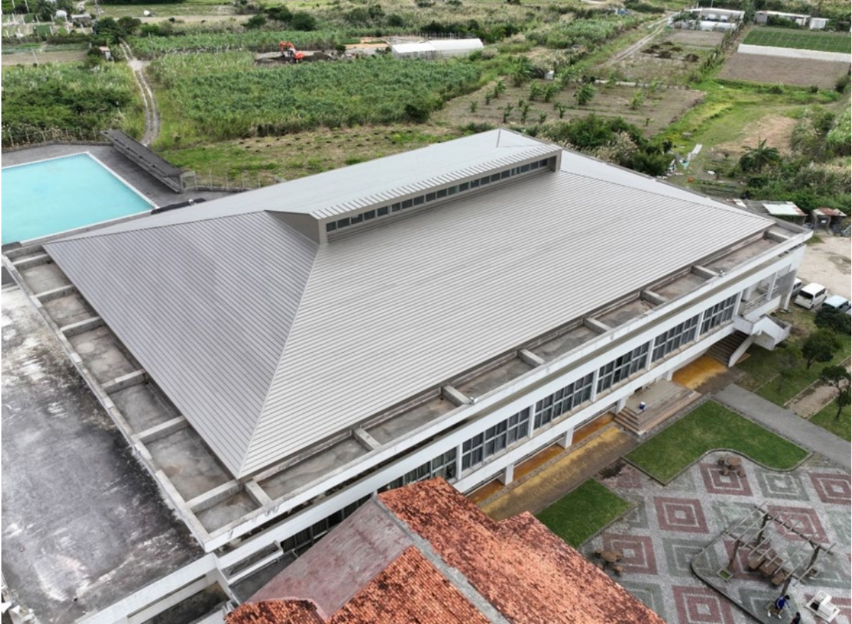
③ 西原東中学校体育館（屋根）
