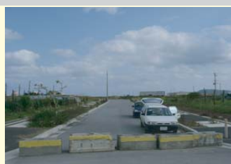
◀ 整備が進められている小那覇マリンタウン線
