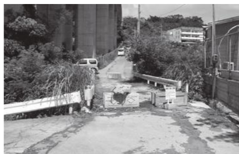
平成25年(通行止め)
