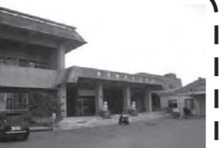
町中央公民館の改修工事や、老朽化した公共施設、学校舎等の設備強化を行います。 【6952万2千円】
