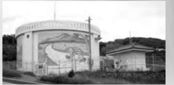
内間配水池 2000t 平成7年3月竣工
