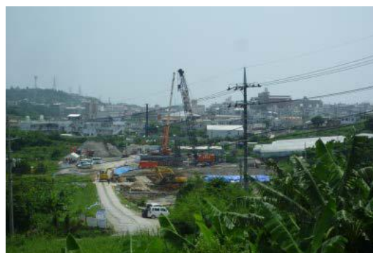
沖縄都市モノレールてだこ浦西駅 建設予定地周辺
