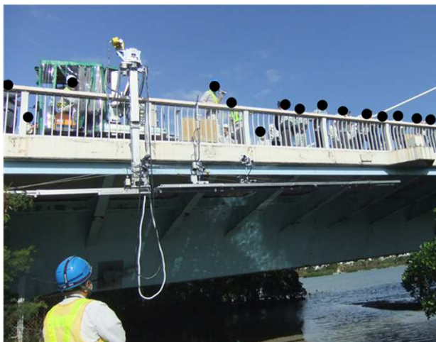
点検ロボットを使用した橋梁点検実施状況(参考)
