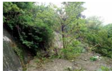
▲池田地内土砂崩れ
